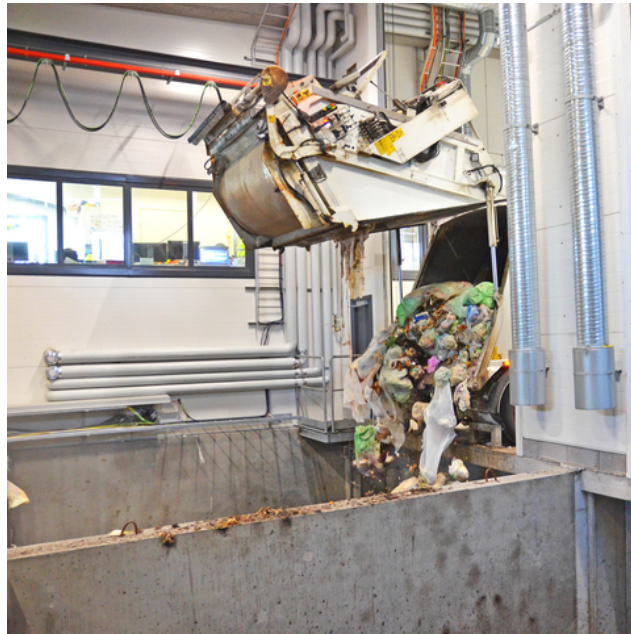
1. Syötteiden vastaanotto, käsittely, hygienisointi ja siirto reaktoriin.
